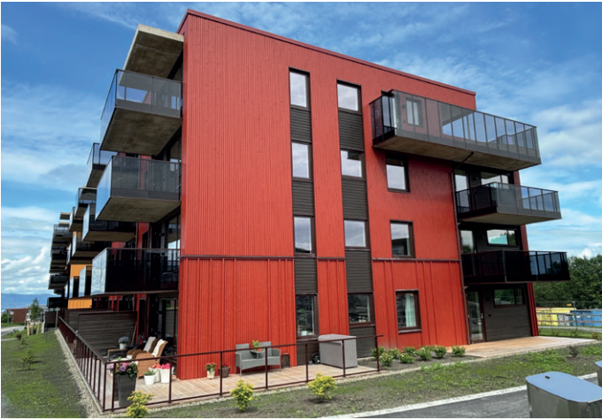
Det sotfargede glasset er lakkert nederst for å skjule betongfronten på balkongen.
